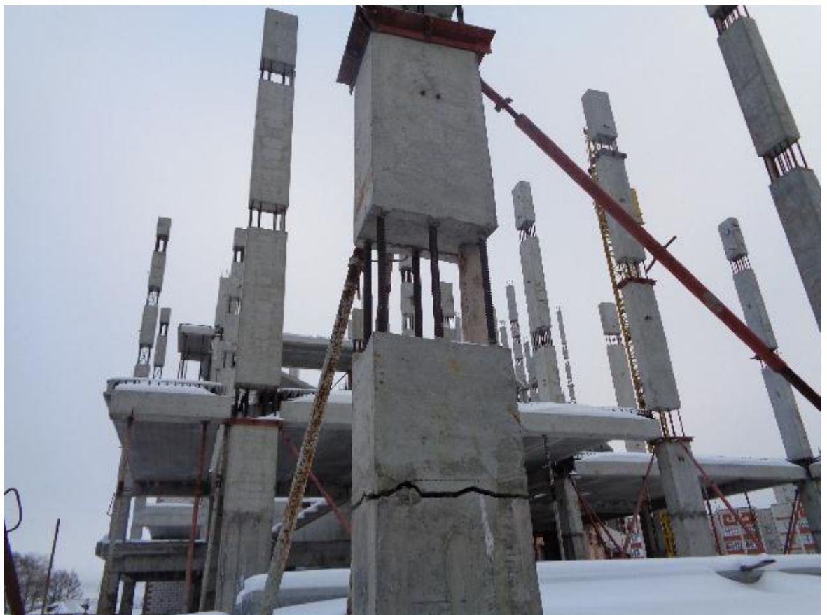
Рис. 1.7. «Приподнятый» от промерзания стык колонн
