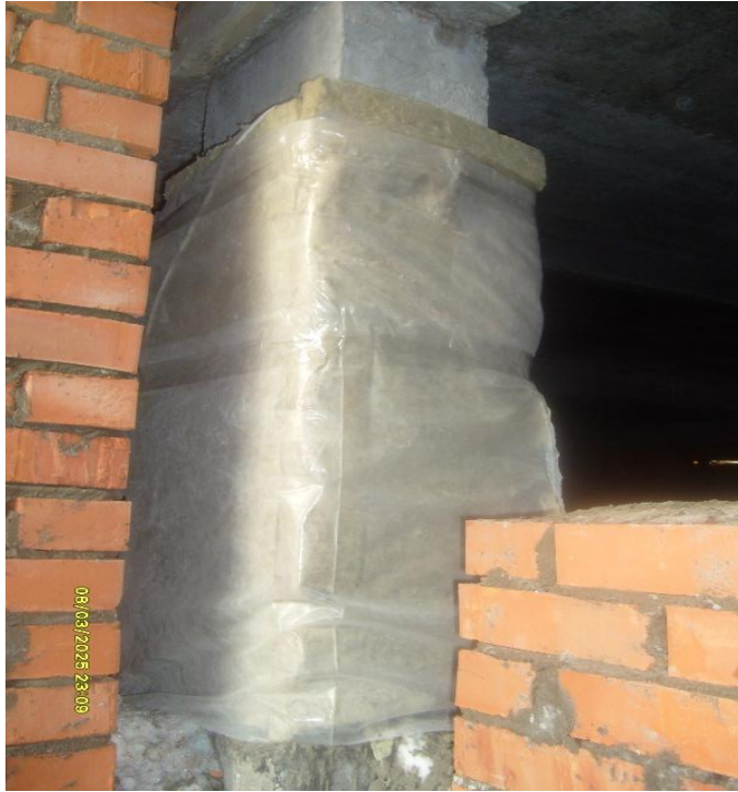
Рис. 5.10. Наружная теплоизоляция штепсельного соединения колонны и фундамента.
