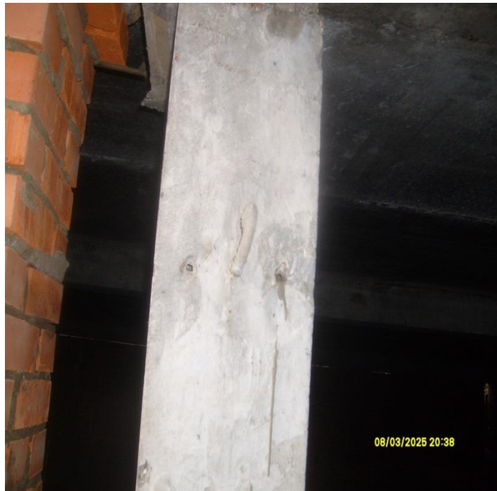
Рис. 5.8. Технологические отверстия диаметром 10 мм для заливки самоуплотняющейся бетонной смеси в штепсельные стыки
