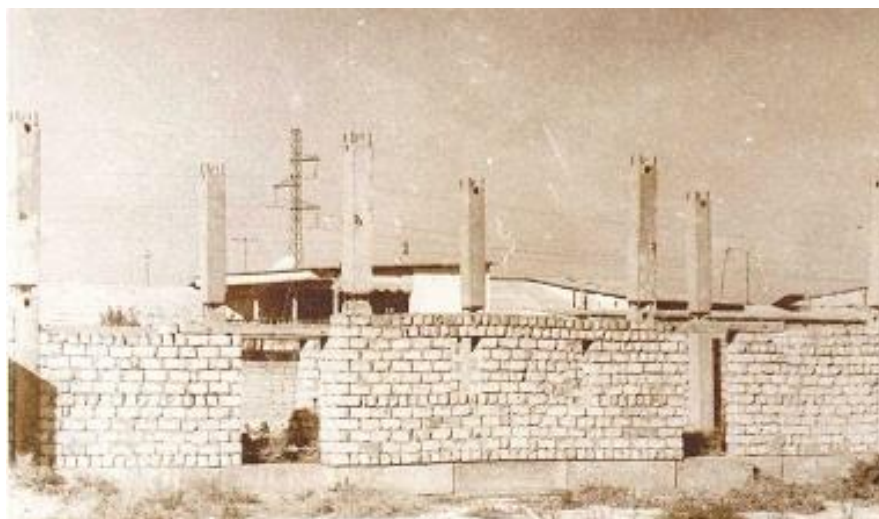
Рис. 7.2. Строительство многоквартирного жилого дома в пос. Заречный Актюбинской области из шлакощелочных блоков
