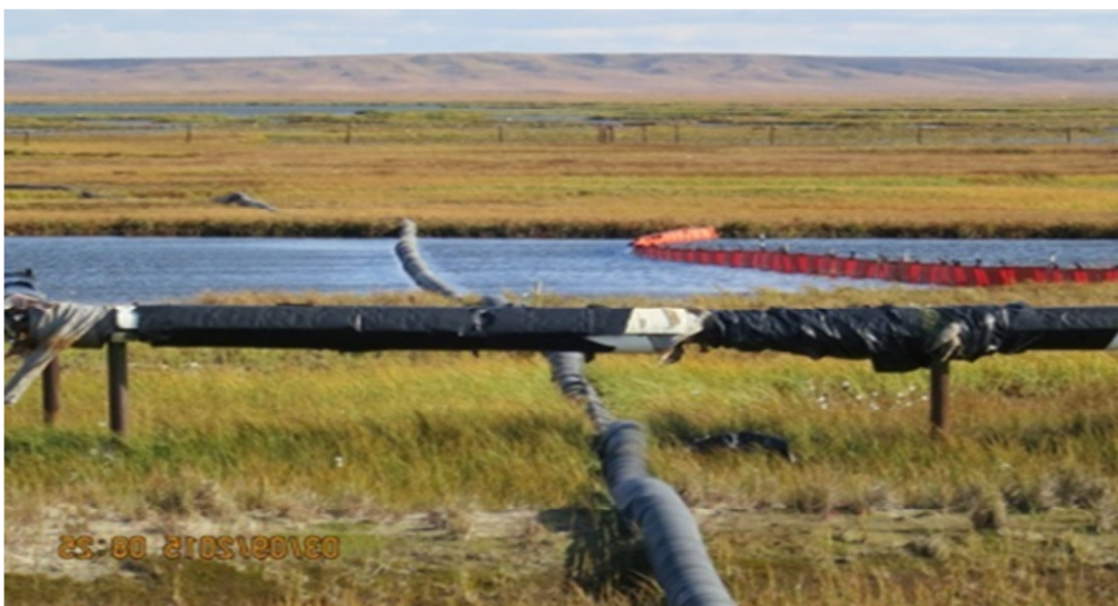
Рисунок 1.8 – Пересечение водной преграды ПГР
