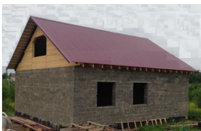
Рисунок 5.5. Малоэтажный дом в селе Каргалы Актюбинской области из шлакощелочных блоков с кукурузным наполнителем
