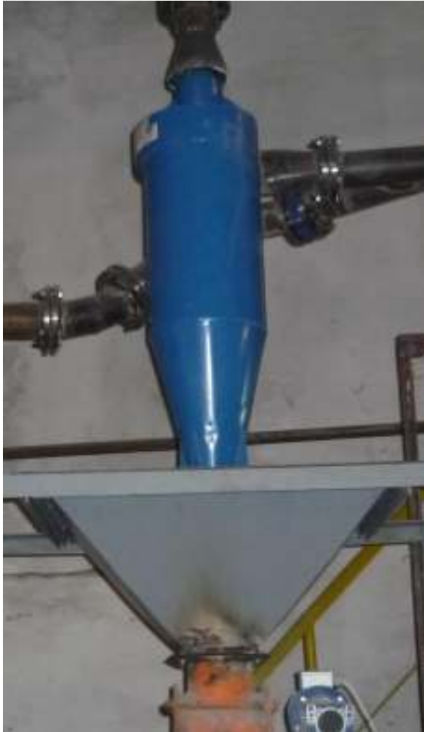
Рисунок 3.5 - Циклон СЦН-40-300
