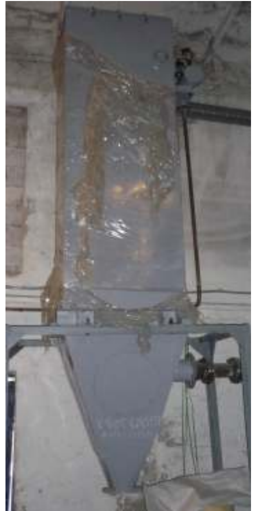
Рисунок 3.6 - Рукавный фильтр ФРКИ-10
