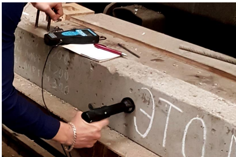
Рис. 5.8. Измерение предела прочности бетона на сжатие неразрушающим методом с помощью прибора ИПС – МГ 4.01
