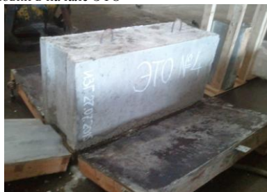
Изделие после распалубки
