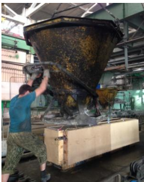
Укладка свежего бетона в опалубку
