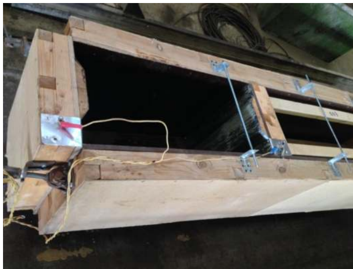
Рис. 4.3. Внешний вид опалубки для изготовления фундаментных блоков с использованием ЭТО электродным методом (опалубка находится в рабочем состоянии, т.е. подготовлена к укладке бетонной смеси для изготовления блока типа ФБС 9.4.6-Т)
