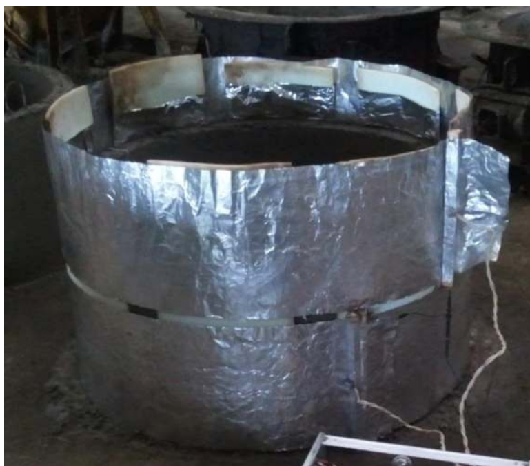
Рис. 4.10. Железобетонное колодезное кольцо типа КС 10.6 после формовки и установки оснастки для выполнения ЭТО
