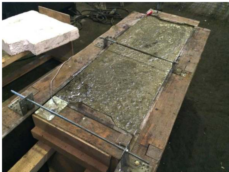
Рис. 5.1. Внешний вид опалубки после укладки и уплотнения бетона при изготовлении фундаментных блоков типа ФБС 9.4.6 (а) и ФБС 12.4.6 (б)
