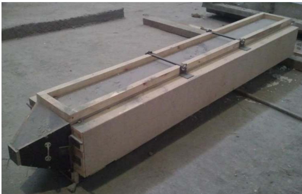
Рис. 4.8. Внешний вид опалубки для изготовления железобетонной сваи с ненапрягаемой арматурой сечением 300x300 мм длиной l = 3 м (ГОСТ 19804-2012) с применением ЭТО электродным методом
