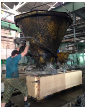
Укладка свежего бетона в опалубку
