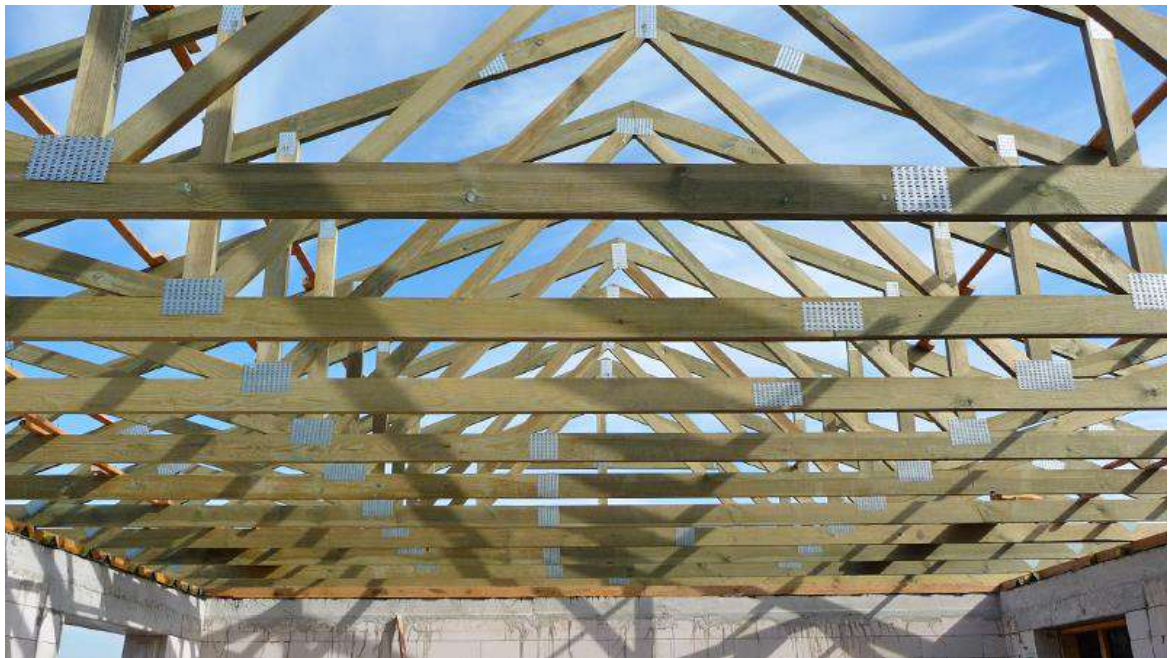
Рисунок 6.6. Вариант конструктивного выполнения деревянной фермы (а) на МЗП и расположение деревянных ферм при устройстве кровельной конструкций
