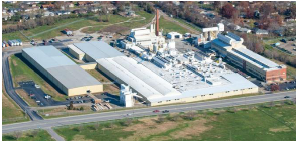
Рисунок 1.1 – Завод по производству пеностекла «Pittsburgh Corning» (США)
