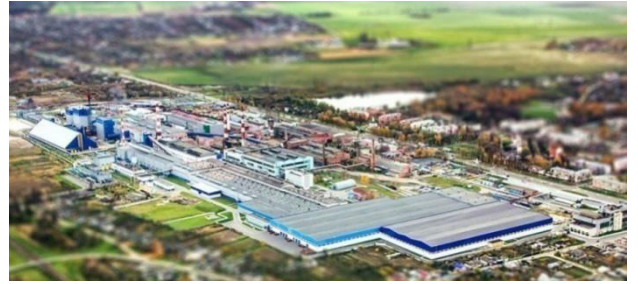
Рисунок 1.2 – Завод по производству пеностекла «Гомельстекло» (Белоруссия)
