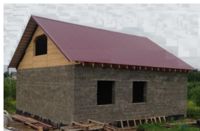
Рисунок 5.3. Строительство малоэтажных домов в поселке Каргалы Актюбинской области из шлакощелочных блоков
