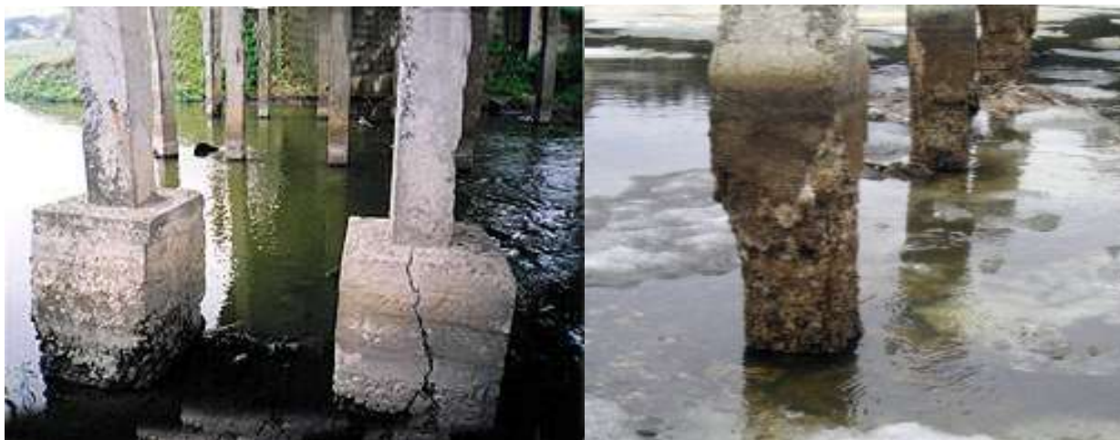
Рисунок 1.4. Разрушение железобетонных опор мостов под действием вод пресного водоёма (обтекание жидкой средой поверхности конструкции)
