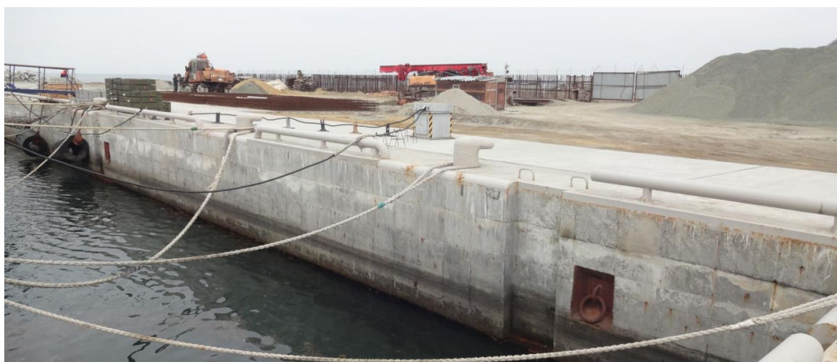
Рис. 2.5. Надстройка причальной стенки из монолитного бетона сооружение КЗ-3 (строительство: 2016-2018 гг.)
