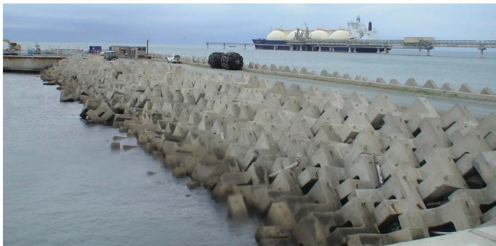
Рис. 2.3. Берегоукрепление корневой части пирса фасонными массивами (гексабитами) на объекте КЗ-1
