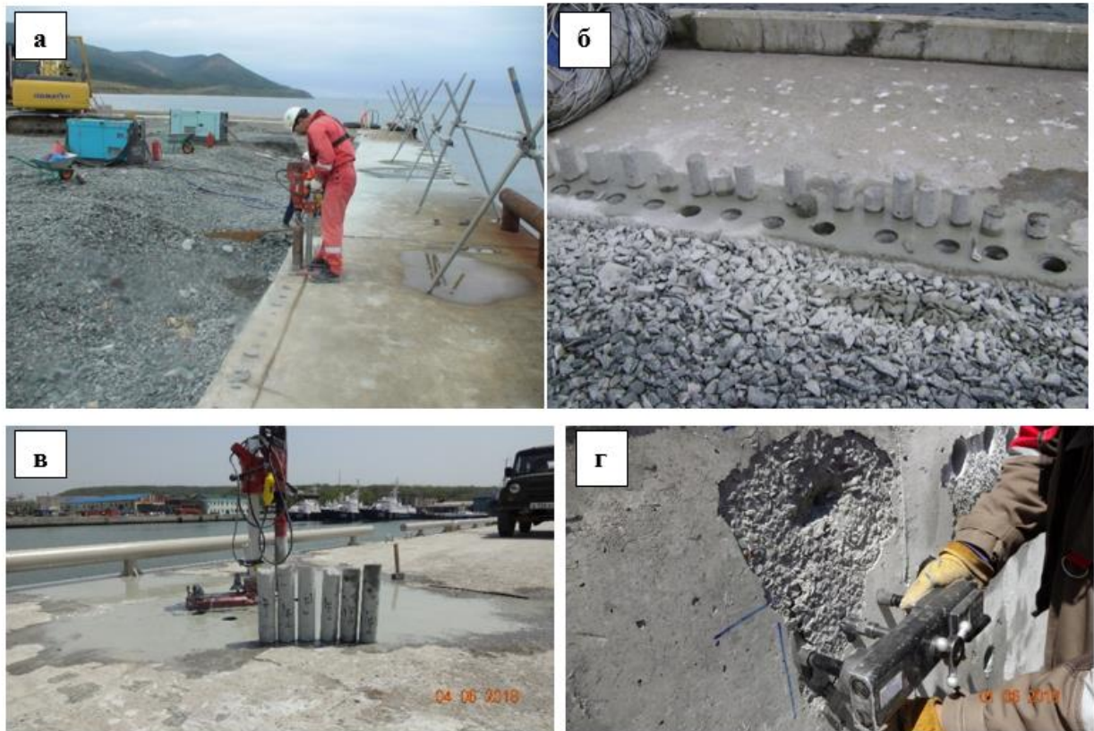
Рис. 3.24. Общий вид работ по отбору проб и испытанию бетона на объекте КЗ-1 (а, б) и КЗ-2 (в, г)
