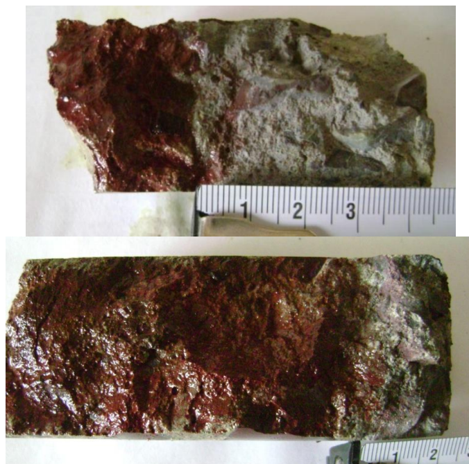
Рис. 3.18. Внешний вид образцов после испытания на наличие в структуре бетона хлорид-ионов. Неокрашенные участки характеризуют глубину проникновения Cl^-
