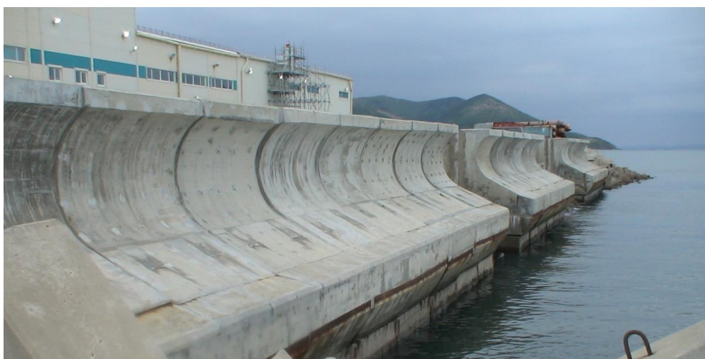
Рис. 2.4. Волноотбойная стенка из сборных фасонных элементов на объекте КЗ-3 (строительство: 2006-2007 гг.)
