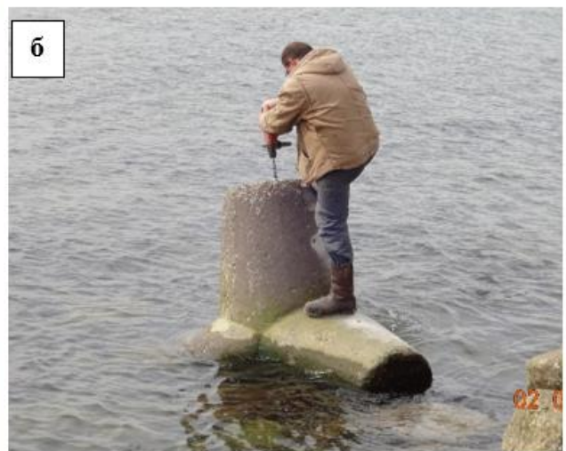
Рис. 3.3. Вид датчика для замера температуры бетона в зоне переменного уровня воды (а), подготовка к установке в конструкцию (тетрапод) датчика температуры (б)
