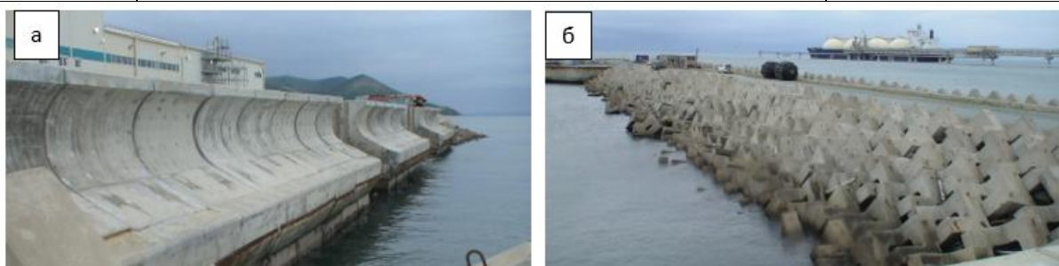
Рис. 1. Общий вид конструкций сооружений: а) волноотбойная стенка из сборных фасонных элементов на объекте К3-2; б) защита корневой части пирса К3-1 гексабитами
