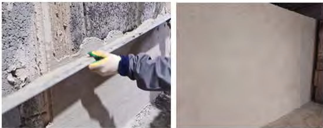
Рис. 5.4. Оштукатуривание стен с применением известковой штукатурной смеси на предприятии ООО «ВЗКГ»
