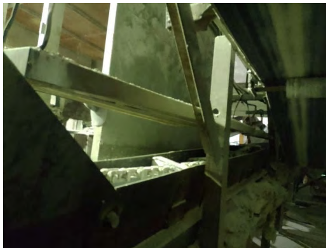
Рис. 5.3. Скребковый транспортер для подачи ИПС с одновременной сушкой
