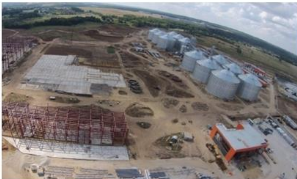
Рис. 3. Строительство биотехнологического комплекса
